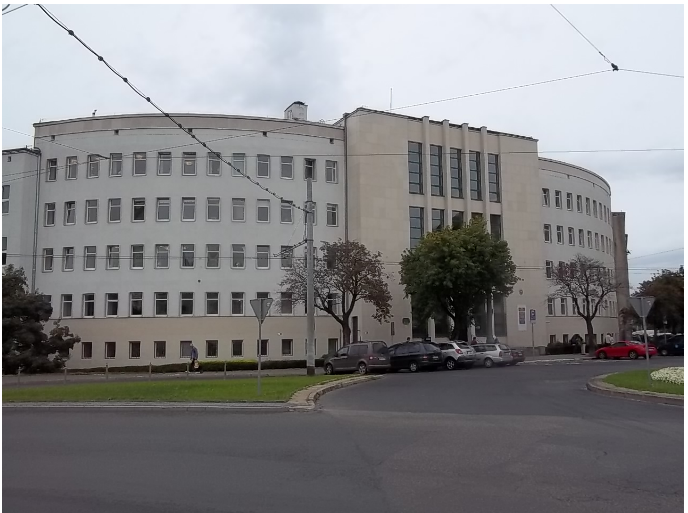
Gmach Sądu Rejonowego w Gdyni; fot.: PrzemaS93, http://pl.wikipedia.org/wiki/Gmach_S%C4%85du_Rejonowego_w_Gdyni#mediaviewer/File:Budynek_S%C4%85du_Rejonowego_w_Gdyni_by_PrzemaS93_(4).JPG
