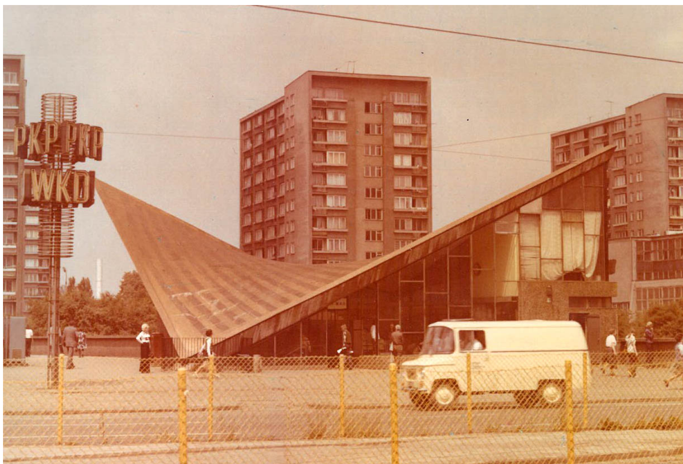
Przystanek kolejowy Warszawa Ochota; fot.: Arseniusz Romanowicz, archiwum SARP
